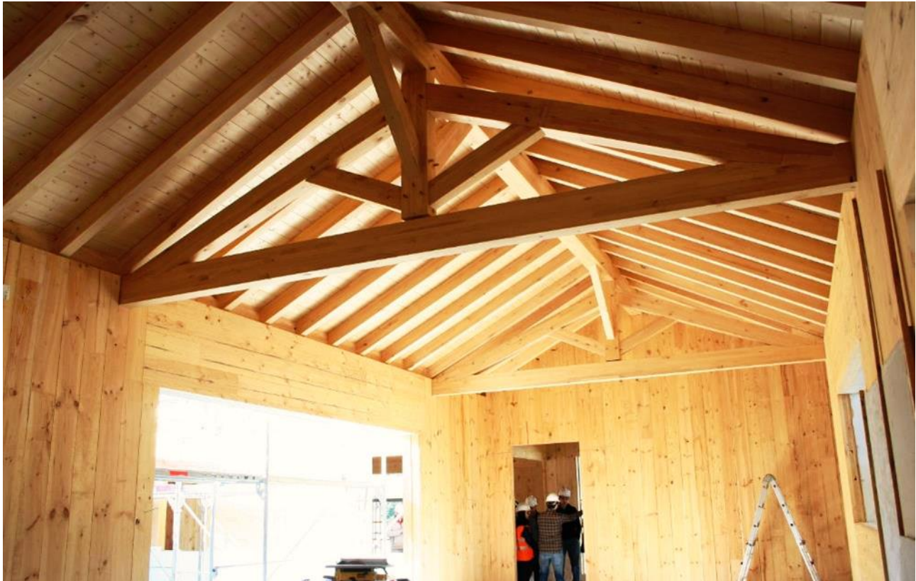
Vivienda Unifamiliar (Madrid). Estudio Torras y Sierra. Visita de obra II Curso Construcción con Madera 2019. Foto M. Esteban
