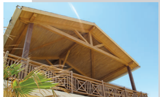
Voladizo y cara visible acabada en una sola operación
