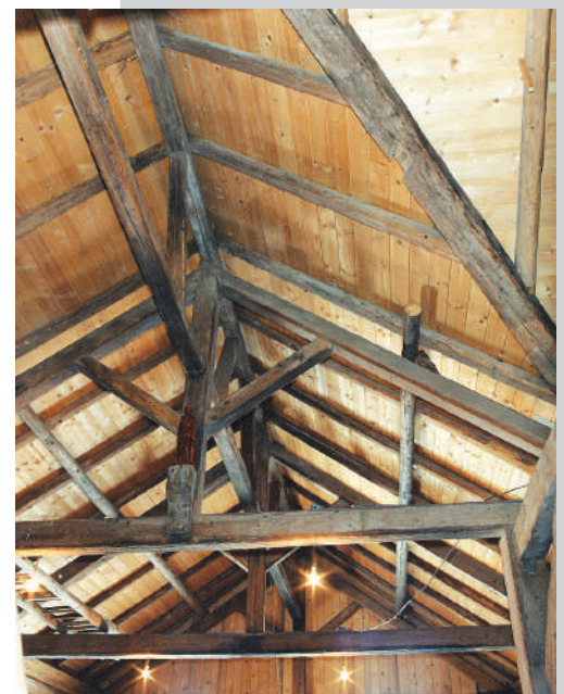
Renovación de cubierta
