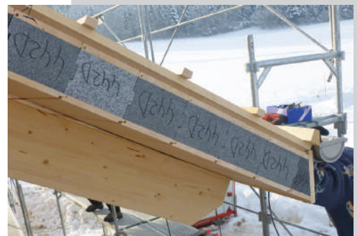
Aislación continua Cara inferior de alero acabada
