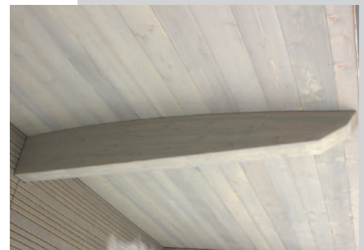
Instalación curva - Perfil n°2 Saturador gris
