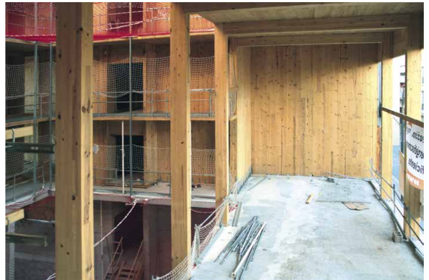
La Borda. Edificio de viviendas. Barcelona, 2018. Autores: Lacol. Fotos: © Lluç Miralles.
